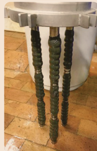
Apertura e pulizia del filtro defangatore IDRAMAG
