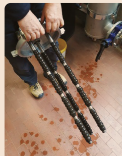
Apertura e pulizia del filtro defangatore IDRAMAG
